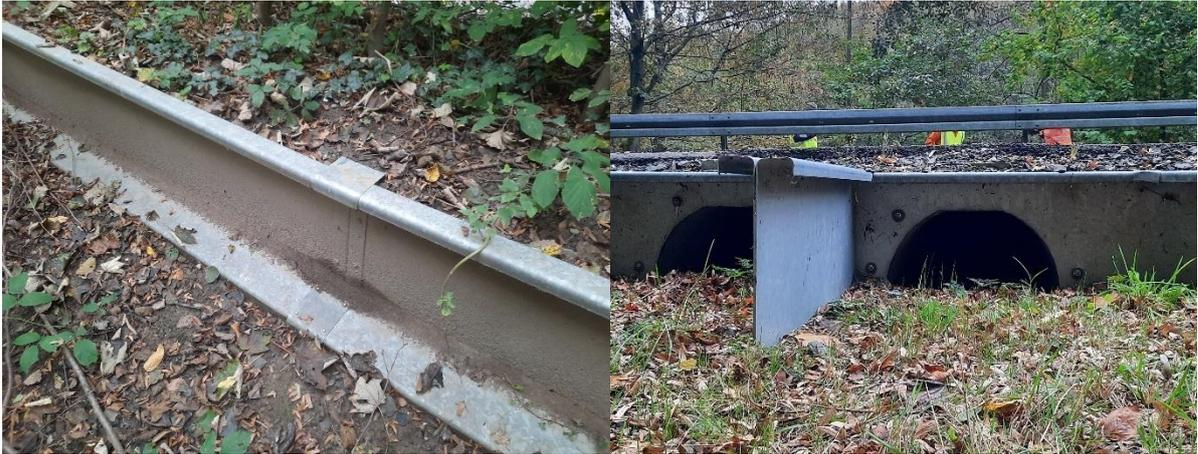
Abbildung 35: Beispiele einer Amphibienleiteinrichtung; links ein nicht überwindbarer fest installierter „Zaun“ sowie rechts ein Durchlass, der unter der Straße entlangführt und beide Straßenseiten miteinander verbindet (eigene Aufnahmen).
