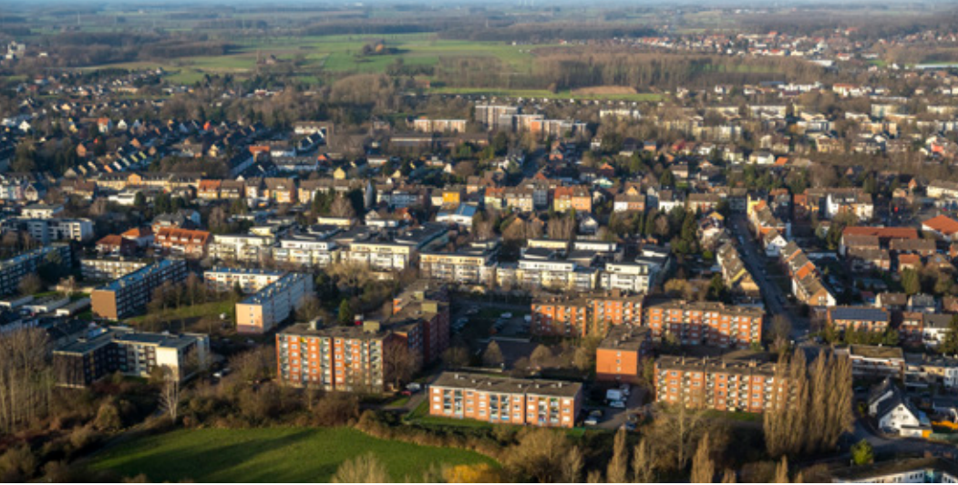
Blick über Hamm-Norden Foto: Hans Blossey
