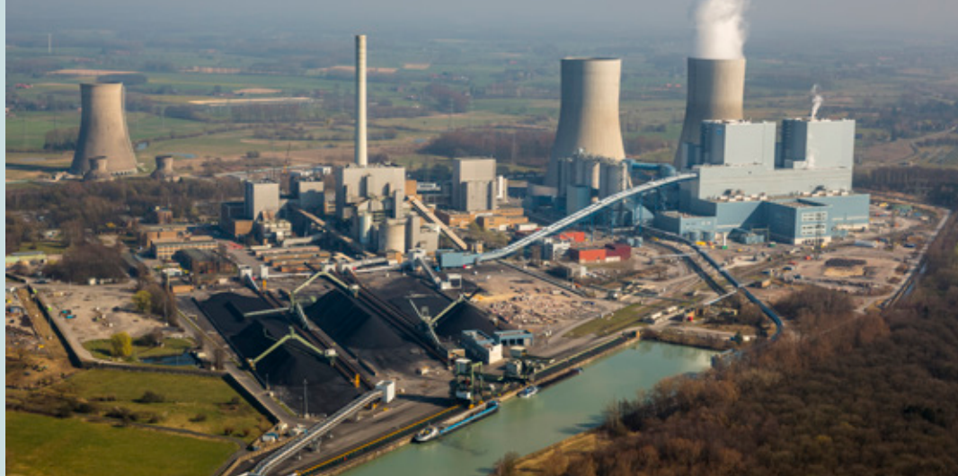
Kraftwerk Westfalen Foto: Hans Blossey
