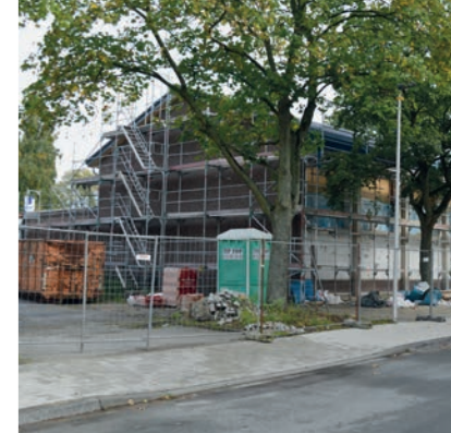
Fassadensanierung der Sporthalle
