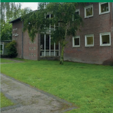
Ostfassade von Haus 1
