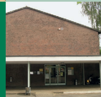
Südfassade von Haus 1 (wird umgebaut)
