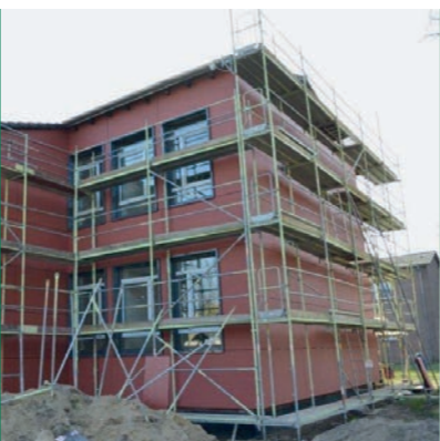
Neue Fenster und Fassadendämmung
