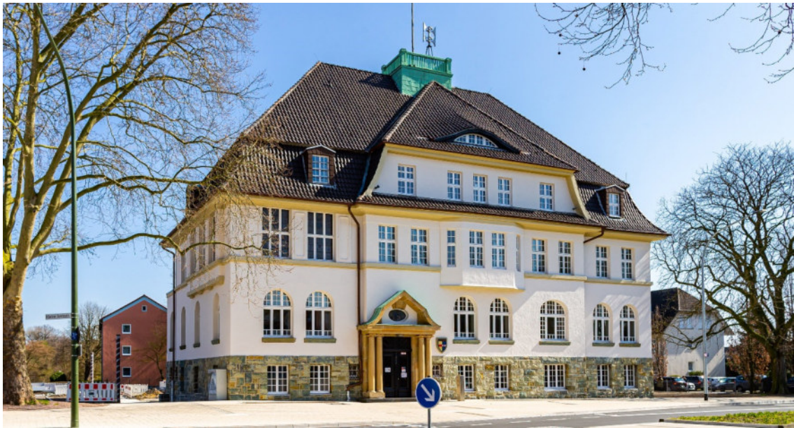
Abbildung 45: Erfolgter Rückbau am Bürgeramt Heessen
