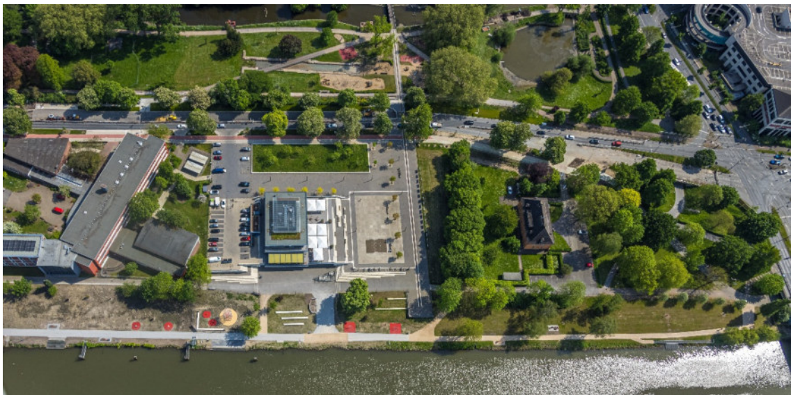
Abbildung 46: Neugestaltung Kanalkante und Chattanoogaaplatz am Wassersportzentrum
