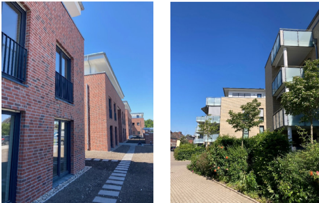
Abbildung 38: Attraktiver Wohnraum im Geschosswohnungsbau
