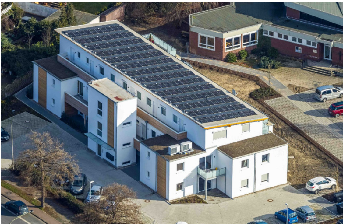
Abbildung 31: Mehrgenerationenhaus Vicanus II mit PV Anlage
