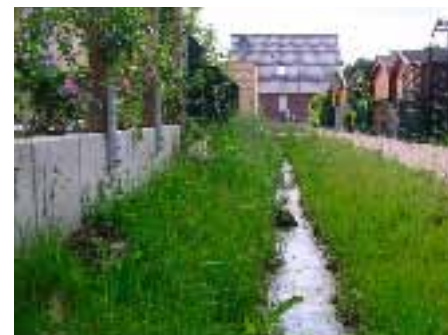
Beispiel für die Entwässerungsmulden
