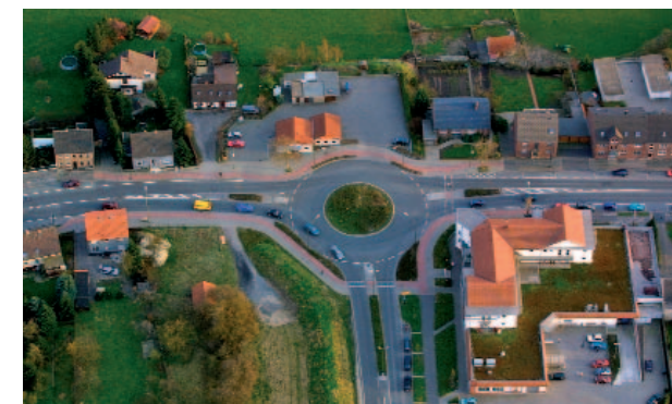
Kreisverkehr Heessener Straße / Sachsenring
