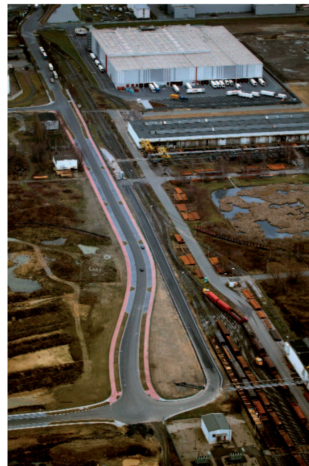
Kanaltrasse: 1. Bauabschnitt bis MHP (2005)
