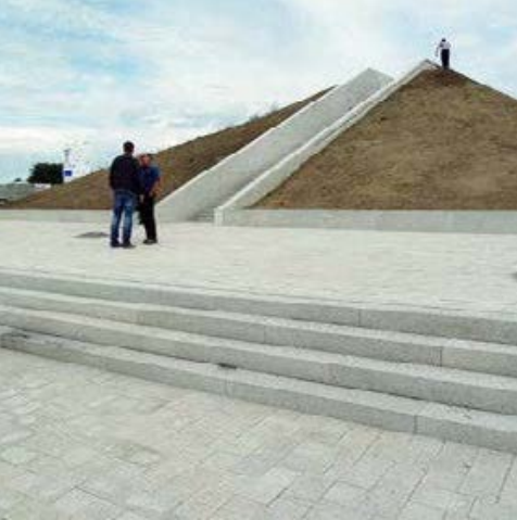
Treppenanlage zum Wall, Bauphase Sommer 2012
