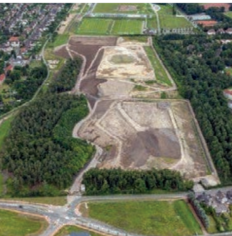
Schacht Franz Nord, Bauphase 2012
