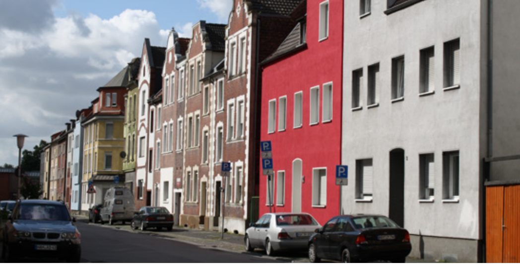
Fassadensanierung in der Silberstraße Foto: Stadt Hamm, Stadtplanungsamt
