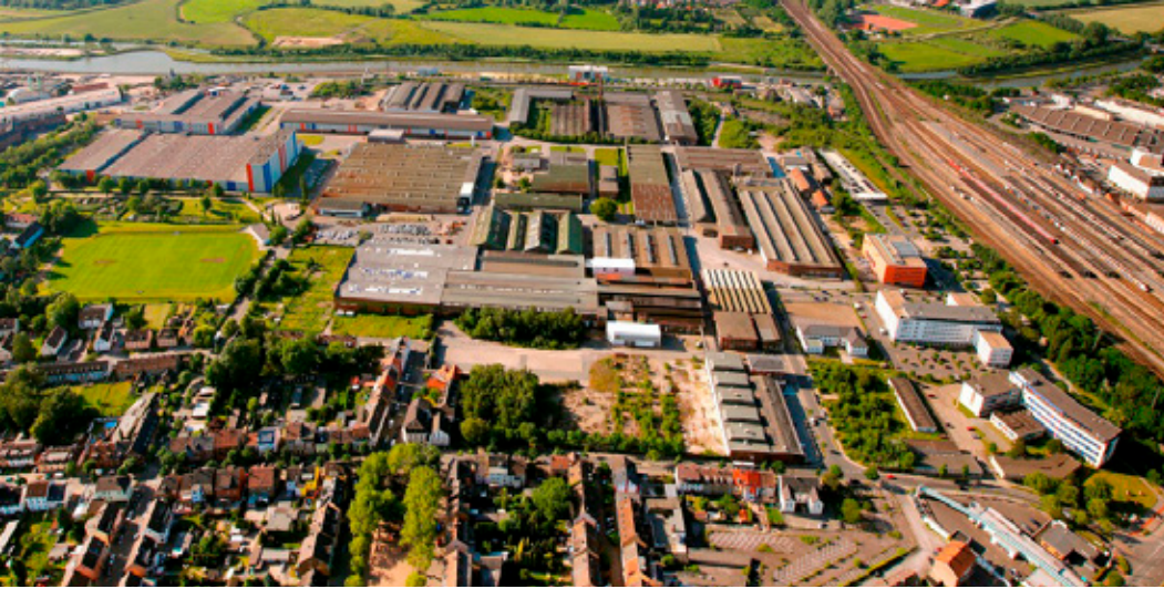
Ehemaliges „Thyssen-Gelände“ Foto: Hans Blossey
