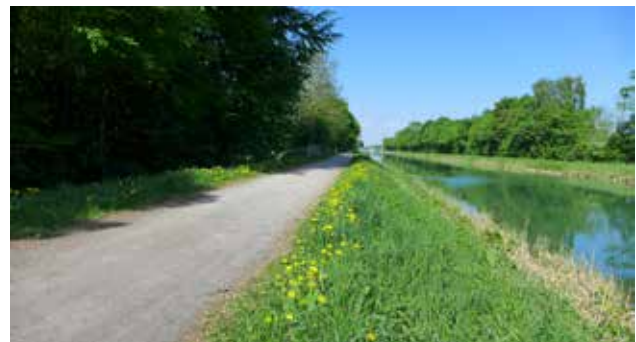
ABB. 21: UFERBEREICH DES DATTELN-HAMM-KANALS
