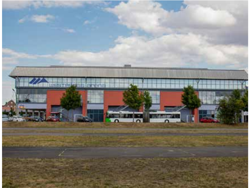
ABB. 47: BLICKE AUF DIE WESTPRESS ARENA
