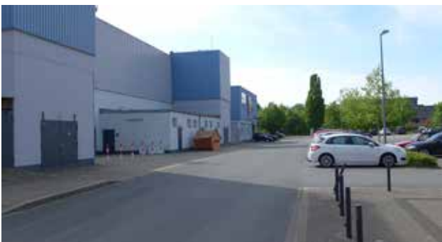
ABB. 12: FUNKTIONALE FASSADE DER EISSPORTHALLE
