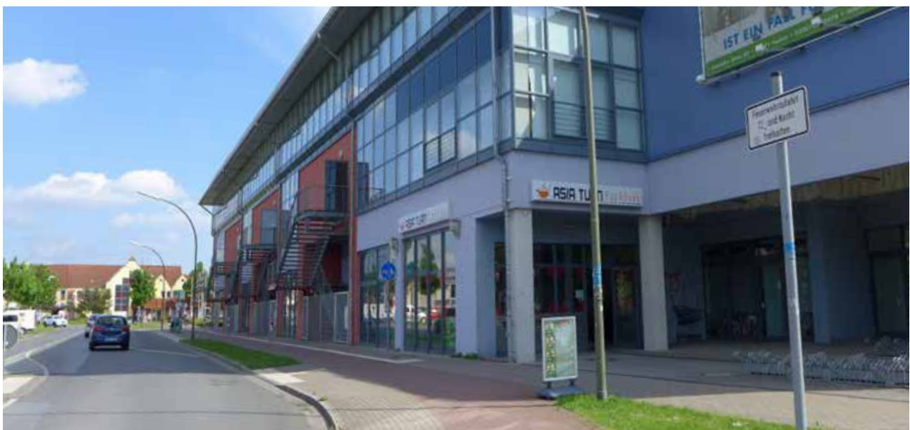
ABB. 34: TEIL DES NEUEN ZENTRUMS WERRIES
