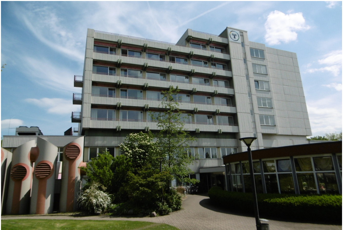
Abb. 26: St. Josef Krankenhaus (Stadt Hamm, Planungsamt)
